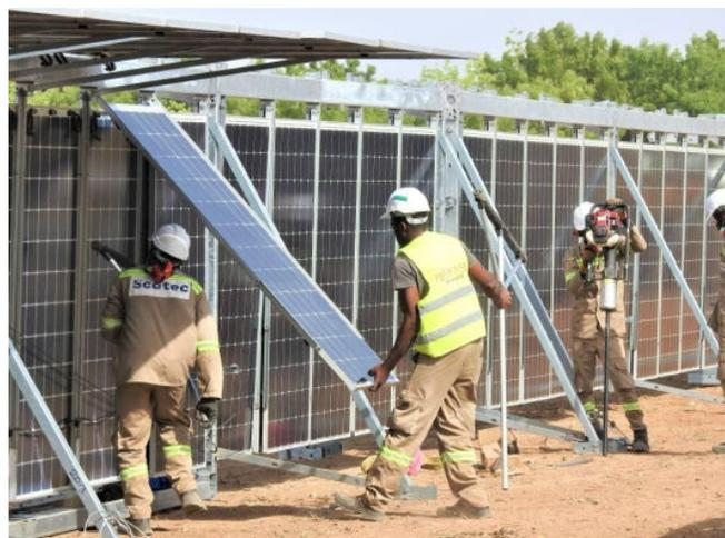
**Installation très rapide** (1 à 2 MW par semaine) grâce à la solution préassemblée et à un enclavage au sol simplifié
