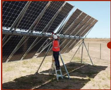
Nous utilisons une technologie PV dernier cri : des modules bifaciaux pour optimiser les performances.
