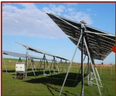
La structure du tracker est fabriquée en acier galvanisé résistant à la corrosion qui s'oriente automatiquement en mode protection en cas de vents forts. Ce système de contrôle est utilisé dans plusieurs de nos projets à grande échelle.
